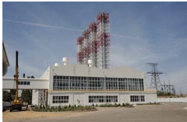
Рис. 3 Когенерационная электростанция «Тиротекс-Энерго»
