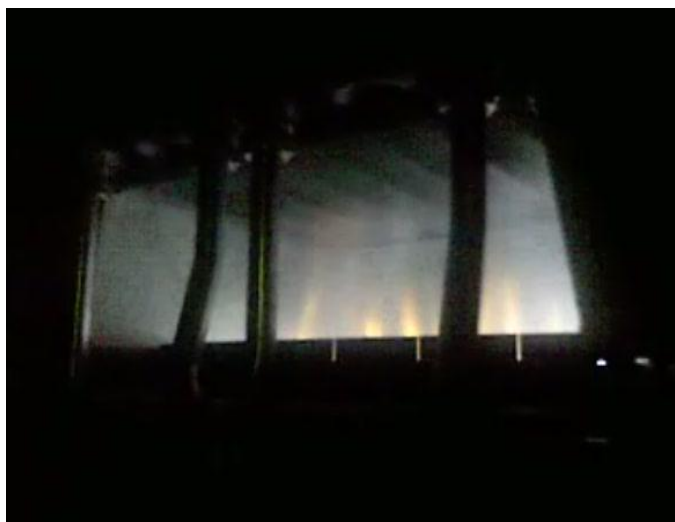
Рис. 1. Робота котла без додаткового обладнання
